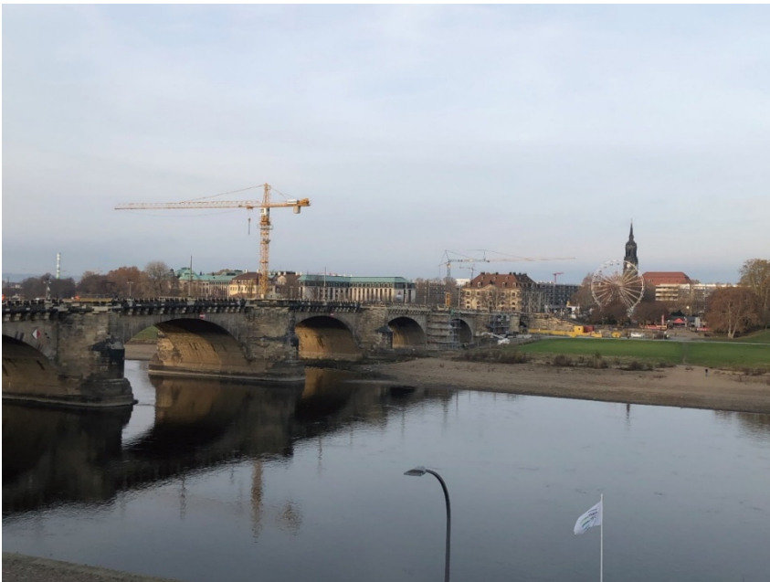
Figura 37 – Reformas na ponte para Altstadt em Dresden, 2019 . Foto do autor.
