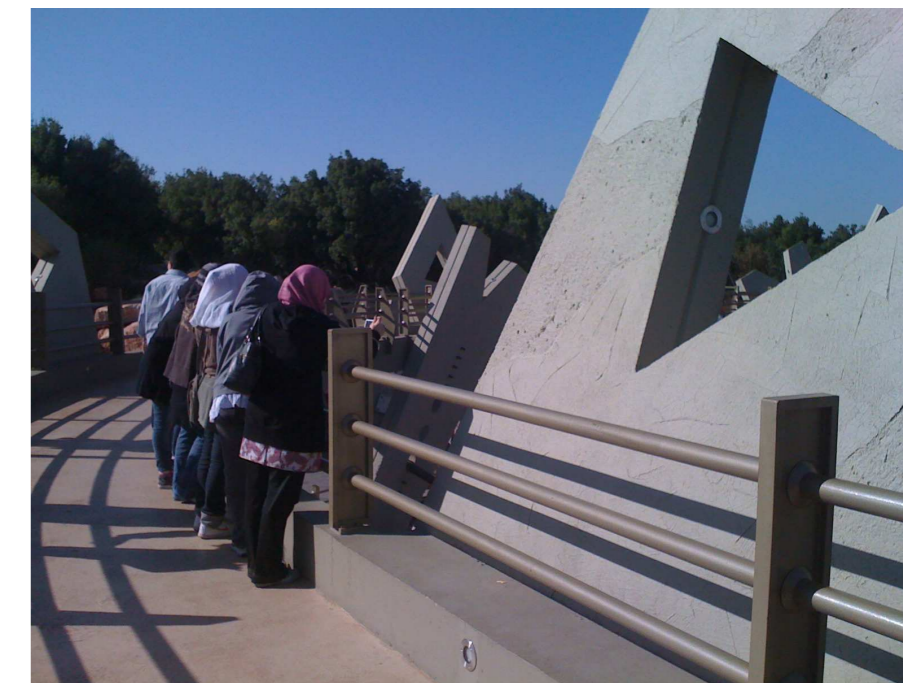
Fig. 94 - Triângulos no concreto.
